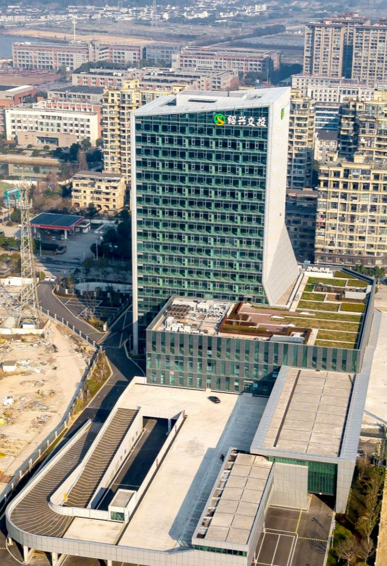
绍兴南部综合交通枢纽项目总用地面积27814平方米，概算总投资48539万元。项目建筑高度85.7米，建筑密度41.6%，容积率2.15，绿地率15%，总建筑面积约79671平方米。项目按照国家二级车站设计，预计日均旅客发送量5000人次，发车位13个，同时结合地铁换乘站、公交换乘站、出租车和网约车停车场，可实现多种运输方式的零距离换乘。
